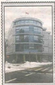
Siedziba Sądu Rejonowego w Chorzowie
